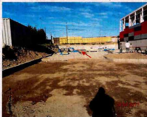
Fotografía N° 3: Ejecución de pavimentos exteriores de hormigón.
