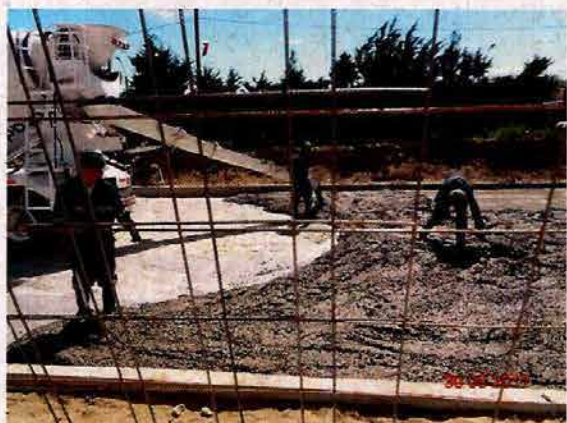
Fotografía N° 5: Ejecución de pavimentos exteriores de hormigón.
