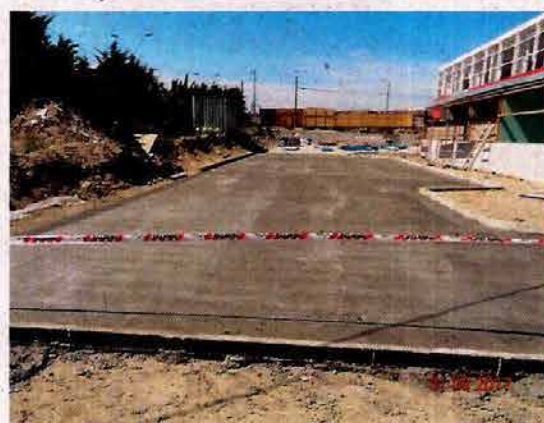
Fotografía N° 6: Ejecución de pavimentos exteriores de hormigón.
