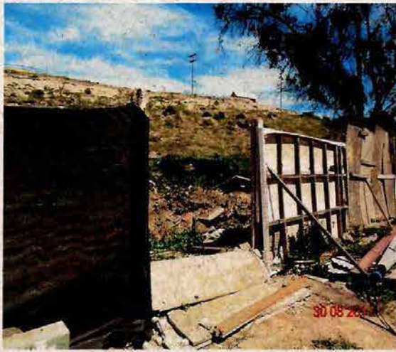
Fotografía N° 21: Presencia de escombros, aledaño al cierre sector sur del recinto.
