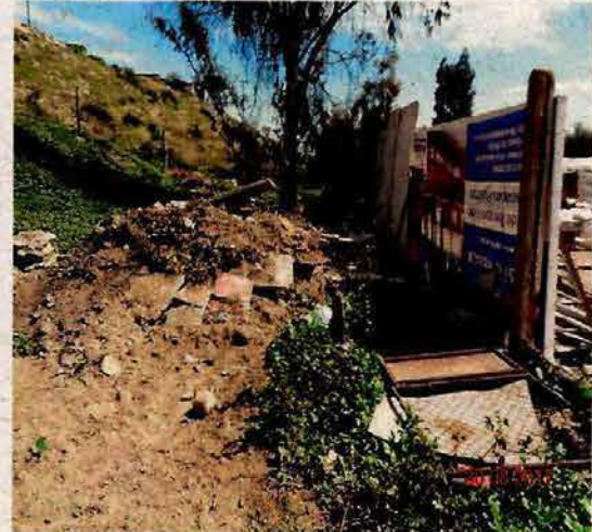
Fotografía N° 20: Presencia de escombros, aledaño al cierre sector sur del recinto.
